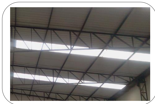
Figura 4: Telhas onduladas translúcidas de policarbonato instaladas
